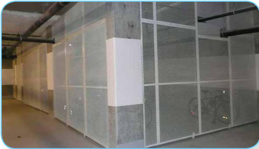
Grillage d'acier du plancher au plafond
